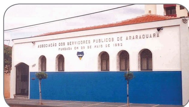
Sede atual na Rua Itália
