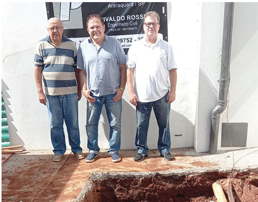
Os diretores da ASPA, Adilson Custódio e Paulo Dimas Cezar com o engenheiro responsável pela obra, Nivaldo Rossi onde começa o projeto de instalação do elevador
